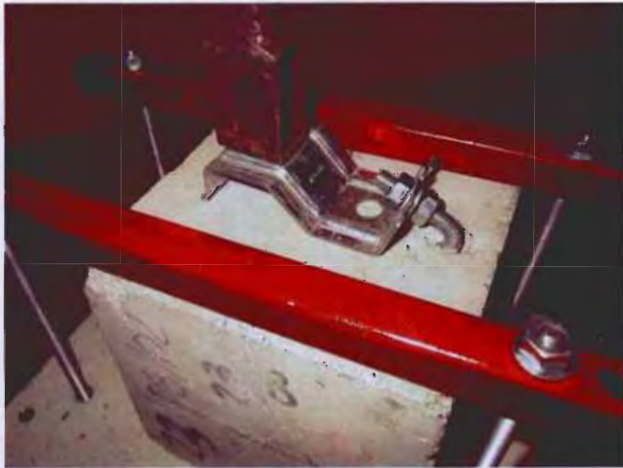
Modalidad de aplicación del anclaje.
